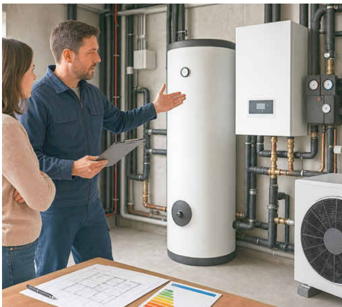
Fachkraft prüft Heizungsanlage und Leitungen im Keller eines Wohnhauses. Foto: KI-generiert
