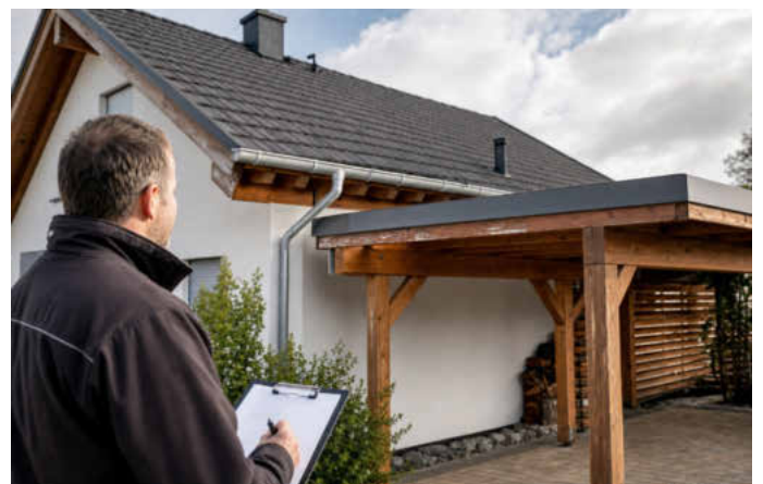
Ein Fachmann prüft vom Boden aus Dachziegel, Regenrinne und hölzerne Bauteile eines Wohnhauses. Foto: KI-generiert
